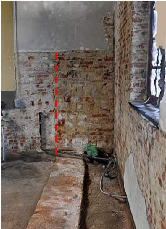
Figuur 8: Een verticale bouwnaad op de muur van het hoogkoor, in lijn met muur 1
