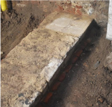
Figuur 10: Detail van muur 2, met bakstenen funderingsvoet, zandstenen parement en ingewerkte grafsteen
