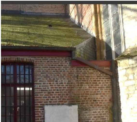
Figuur 17: De vreemde hoekconstructie aan het raam van het hoogkoor
