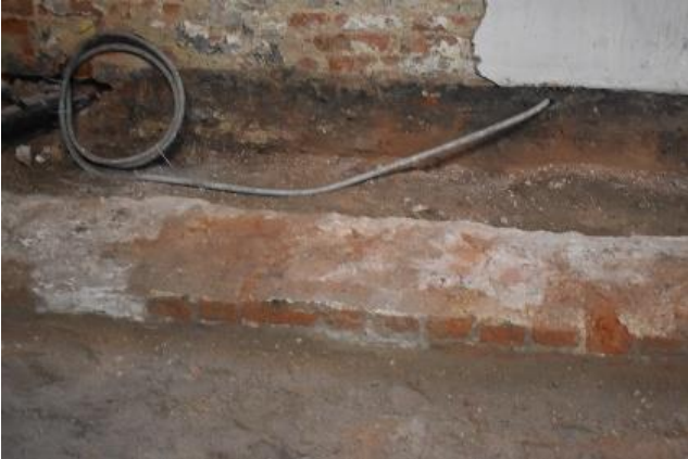
Figuur 6: Detail van muur 1
