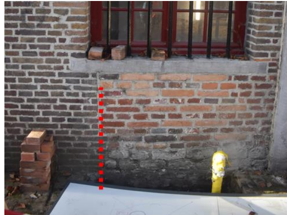
Figuur 11: Sporen van een zandstenen parement aan de buitenzijde van de sacristie. De rode lijn correspondeert met muur 2 aan de binnenzijde van de sacristie
