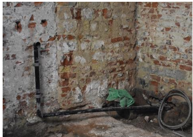
Figuur 18: Egalisatie van de wand met onder meer tegels, na afbraak van muur 1
