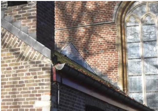
Figuur 15: Bouwporen van een zadeldak op de muur van het hoogkoor
