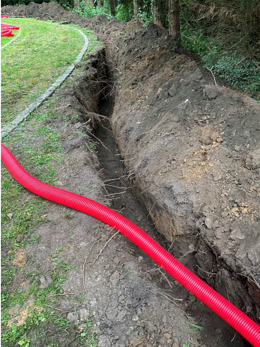
Opmenging van de sleuven voor de nutsleidingen in zone II, de motteheuvel bevindt zich links
