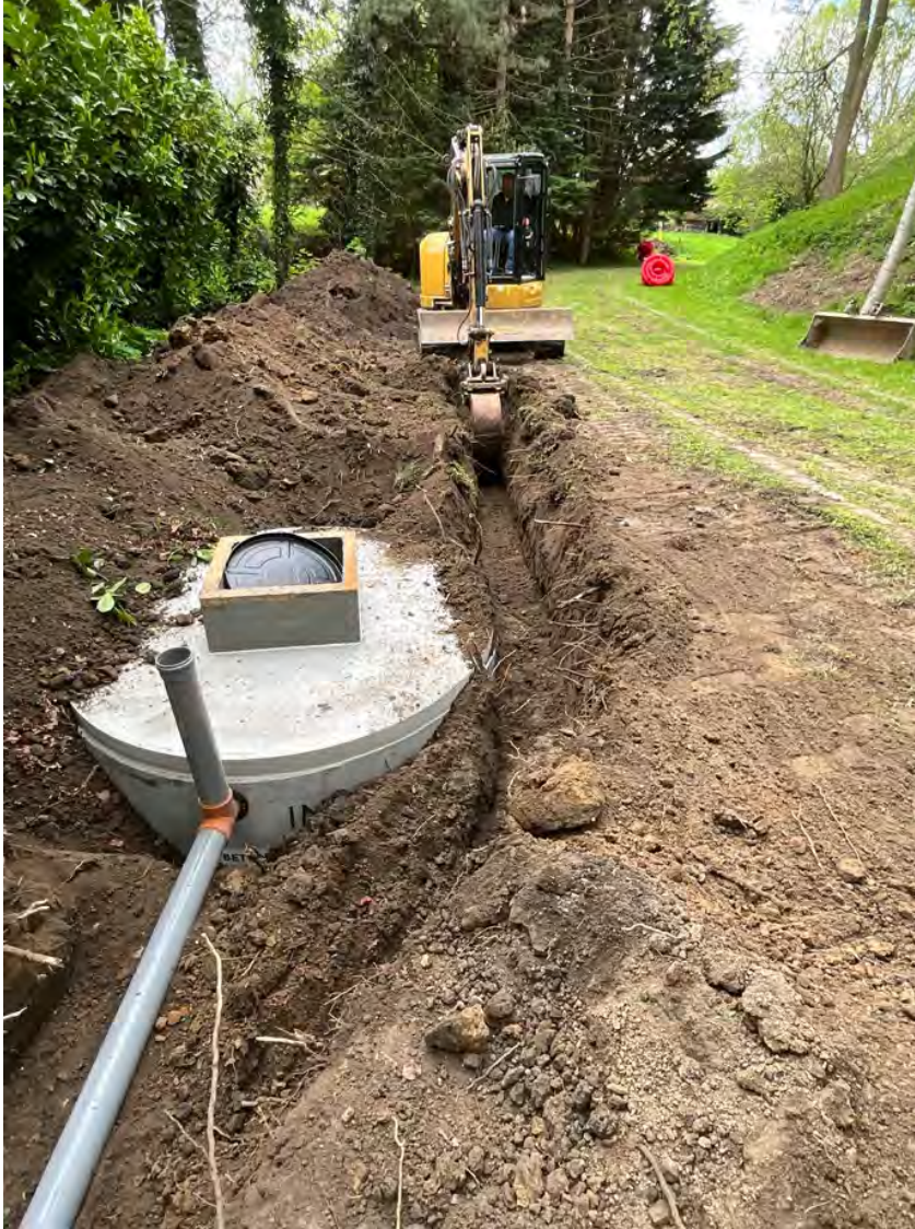
Opvolging van de sleuven voor de nutsleidingen in zone II, rechts bevindt zich de voet van de motteheuvel
